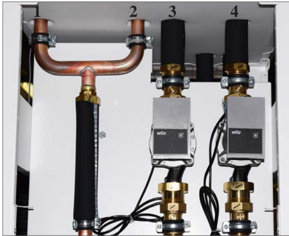
Fig. 13: Hydrobloc monté dans la pompe à chaleur
